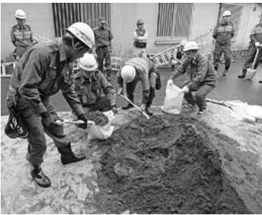
建設協会の指導のもと、団員が土のうを作成
